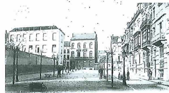
Het Bossuetplein, heraangelegd in het begin van de 20 e eeuw, met als doel het centrum van de gemeente van het verkeer te ontlasten en te herwaarderen. Postkaart Dexia Bank
